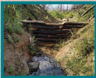
Αντιδιαβρωτικά & αντιπλημμυρικά έργα | Βαρυμπόμπη
