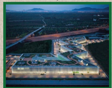
Καινοτόμο βιοκλιματικό κτήριο | Karela Office Park - Παιανία
